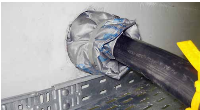
HSS – inbouw in kernboringen met HRD rubberafdichtingen
