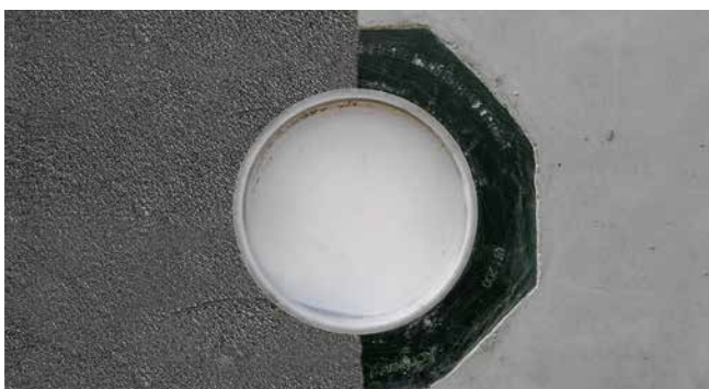
gebetonneerde UFR met PMBC
