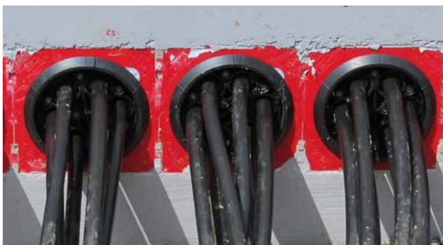
afdichting van laagspanningskabels met HSI150 DG 6x10-36
