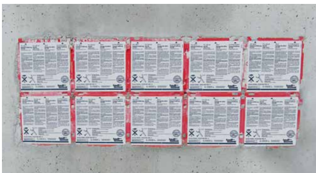
dubbele dichtpakking HS1150 als pakket in bekisting geplaatst
