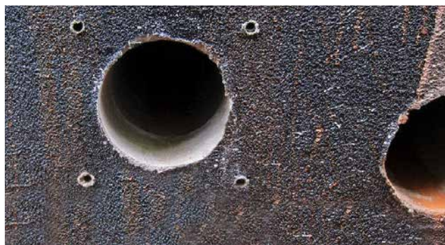
boring en plugopeningen
