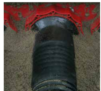
geribde mantelbuizen met koude HSI150 D1x110 KS WR
