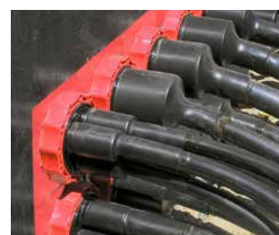
stationsuitvoering: laagspanningskabel afgedicht met HSI90 D1x75 WS en HSI90 D3x32 WS
