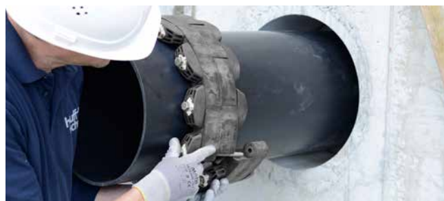
GKD400 – aanbrengen van de segmenten
