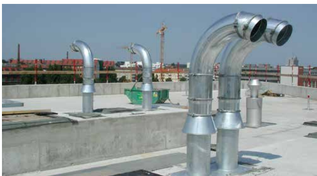
gemonteerd SHD 200 voor verlegging van dakafdichting
